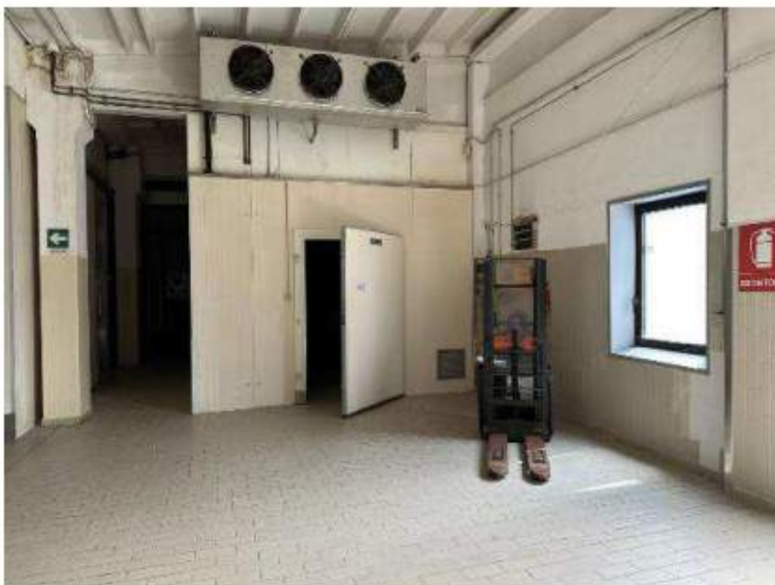
Piano secondo. Cella 10/B: Stagionatura. Mod. Travaglini LSS 110.3 Kw. Anno di messa in servizio: 1986. Particolari finiture interne. Carrelli inox a ripiani.
