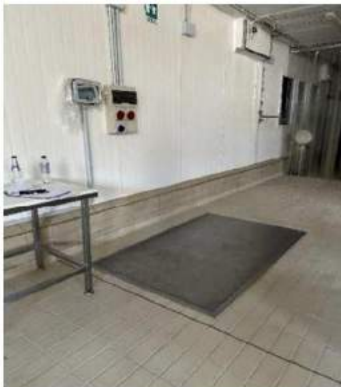
Piano terra. Cella 13: insacco prodotti. Pesa a terra scarico prodotto congelato. Mod. Bilanciai EV22. 20 w - cod. 01-016
