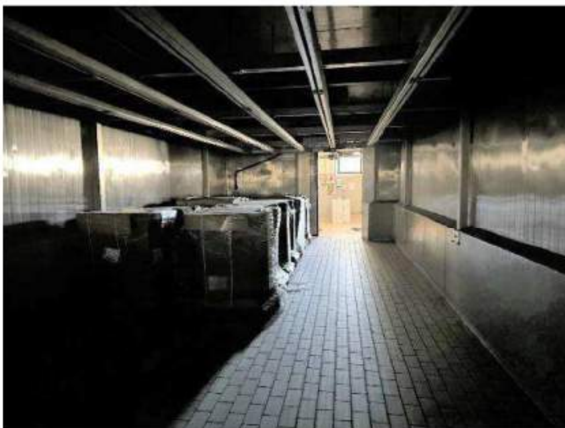
Particolari finiture interne. Piano terra. Cella 6: carne fresca. Cella 0 > 2° salagione suino. Mod Travaglini 7509-13/2. 8,5 Kw. Anno di messa in servizio: 1992. Vista binari a soffitto per trasporto insaccati. Si evidenziano bancali di scatole di cartone.
