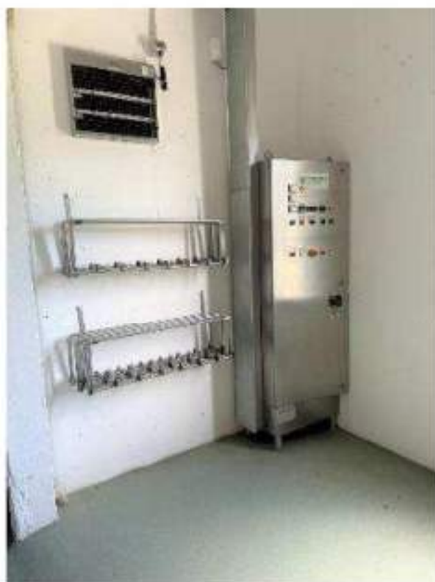
Piano secondo. Locale n.44. Lavaprodotti. Mod. Colussi Ermes 5191. 55 Kw. Anno di messa in servizio: 2004, 03B-000
