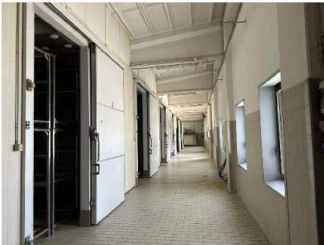
Piano secondo. Corridoio lato nord e Cella 5/B: Stagionatura. Mod. Travaglini WS 51. 25,3 Kw. Anno di messa in servizio: 1985. Particolari finiture interne. Carrelli acciaio inox portasalumi.
