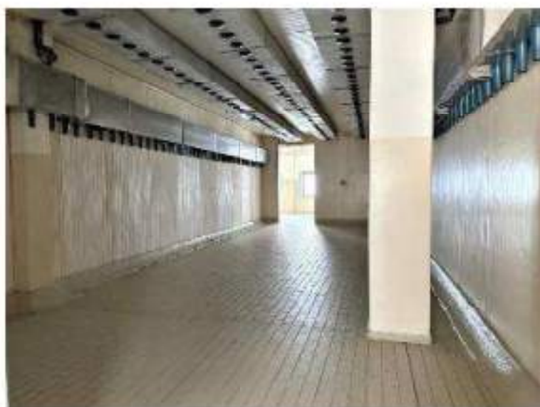
Piano secondo. Cella 9/B: Stagionatura. Mod. Travaglini WAS 300 P.C. 22,5 Kw. Anno di messa in servizio: 1987. Particolari finiture interne. Sala macchine.
