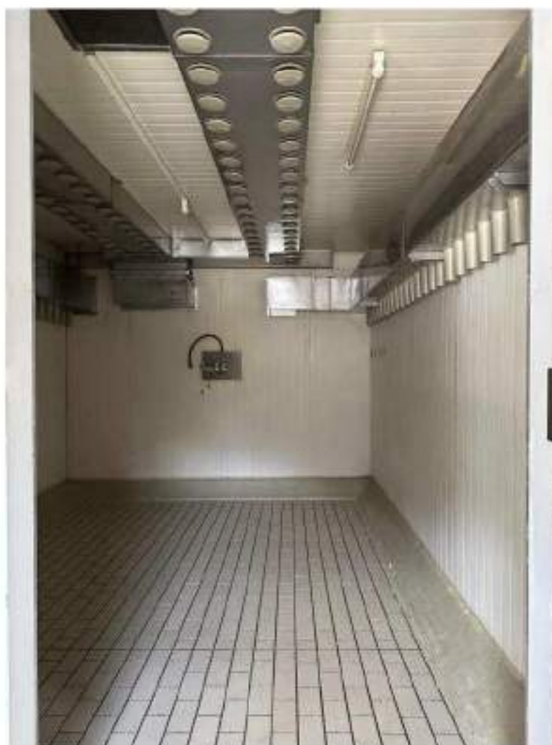
Piano primo. Cella 4/A: asciugamento. Essiccatore. Mod. Travaglini WA 12 P.C. 16 Kw. Anno di messa in servizio: 1985, Particolari finiture interne.
