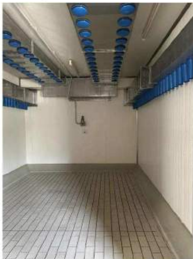
Piano primo. Cella 7/A: asciugamento. Essiccatore. Mod. La Frigotecnica ASR 150A. 19 Kw. Anno di messa in servizio: 1985, Particolari finiture interne.
