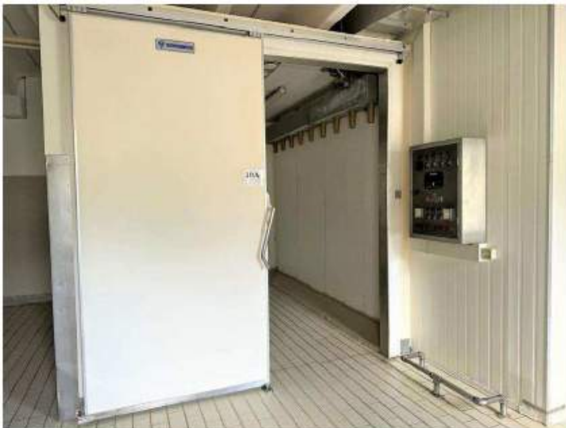
Piano primo. Cella 10/A: asciugamento. Essiccatore. Mod. Travaglini WA 120.0056. 6Kw. Anno di messa in servizio: 1986. Particolari finiture interne.
