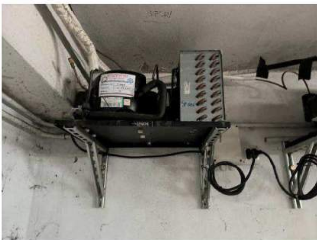
Impianti frigoriferi locale bar/tavola calda/spaccio. Cod. SP-006, ubicati nel deposito al sub.13.
