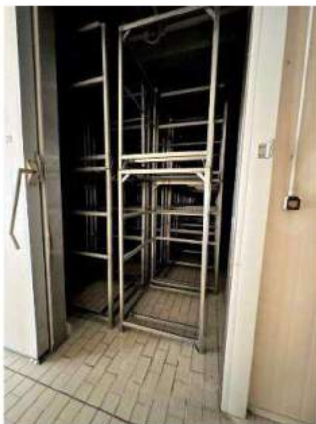
Piano secondo. Cella 2/B: Stagionatura. Mod. Travaglini 4888/EL2.17 Kw. Anno di messa in servizio: 1987. Particolari finiture interne. Carrelli acciaio inox portasalumi, e n.1 transpallet
