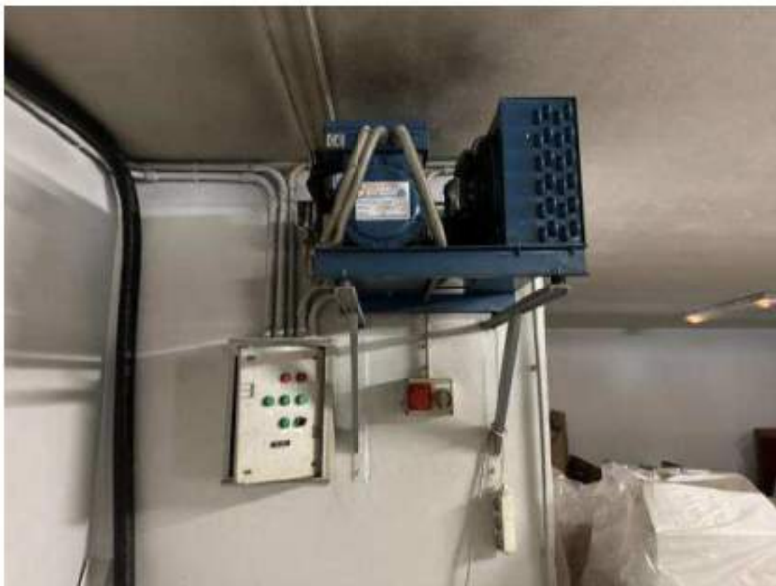
Cella salumi Mod. Mondialgroup. 0,850 Kw. Anno di messa in servizio: 2007. Cod. SP.-013 Impianto ubicato nel deposito al sub.11
