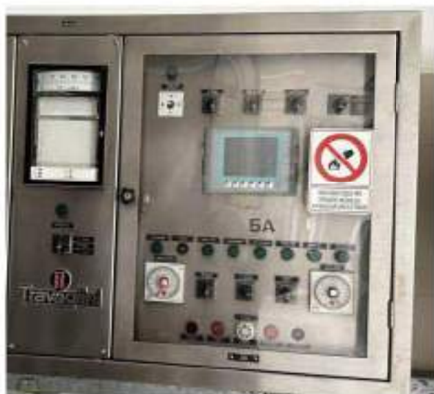
Piano primo. Cella 5/A: asciugamento. Essiccatore. Mod. Travaglini WA 12 P.C. 16 Kw. Anno di messa in servizio: 1985, Particolari finiture interne.
