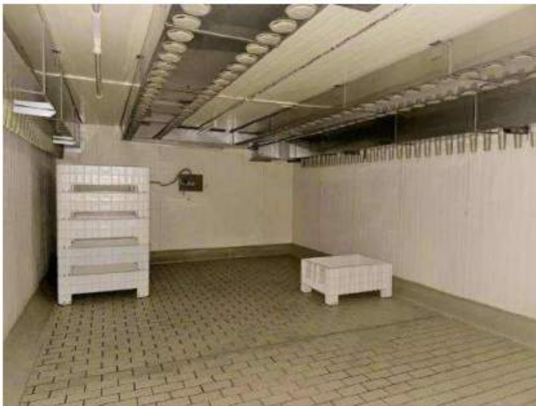
Piano primo. Cella 1/A: asciugamento. Essicatoio. Mod. Travaglini WA 20 P.C. 25 Kw. Anno di messa in servizio: 1985, Particolari finiture interne, n.16 vasche bianche in plastica.
