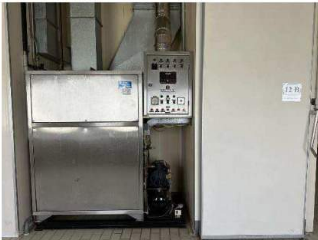
Piano secondo. Cella 12/B: Stagionatura. Mod. Travaglini WA 120.1452. 8 Kw. Anno di messa in servizio: 1990. Particolari finiture interne.
