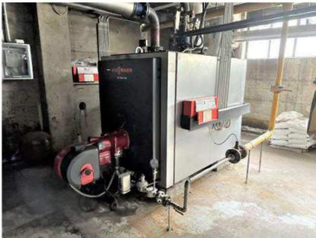
Piano seminterrato C.F. Fig.7 mapp.236 sub.4 : centrale termica 34 - Finiture interne, particolari impianti. Caldaia. Mod. Viessman. VITOPLEX 100 - SX 1 + pompe. Anno di messa in servizio: 2008 Cod.00-005
