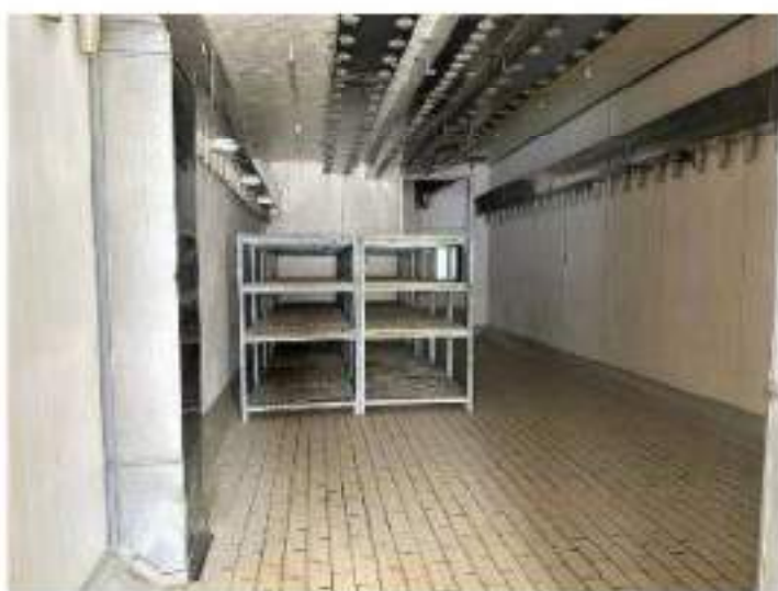
Piano secondo. Cella 3/B: Stagionatura. Mod. Travaglini 2WS/36 PC. 23,5 Kw. Anno di messa in servizio: 1985. Carrelli acciaio inox con ripiani. Particolari finiture interne.
