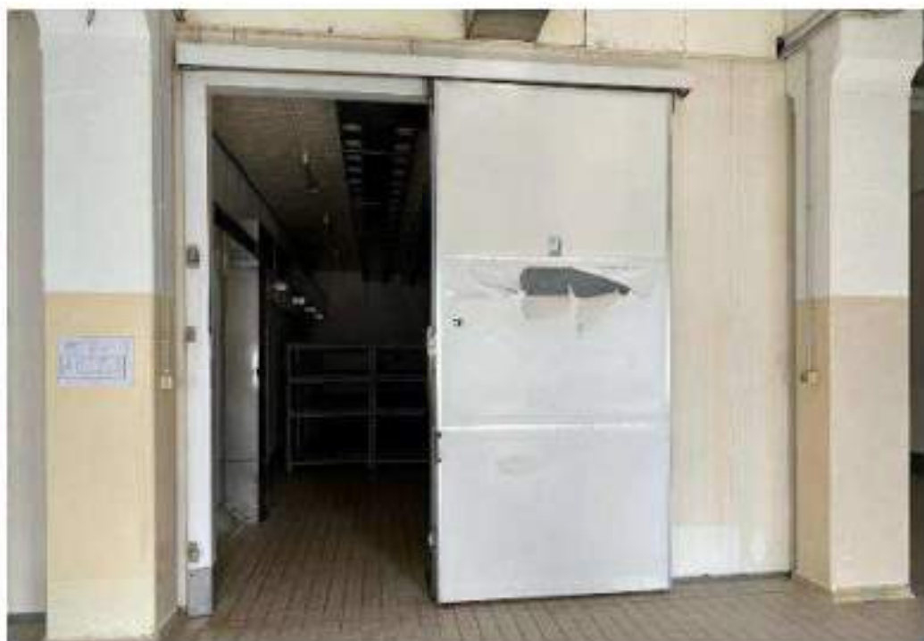
Piano secondo. Cella 3/B: Stagionatura. Mod. Travaglini 2WS/36 PC. 23,5 Kw. Anno di messa in servizio: 1985. Carrelli acciaio inox con ripiani. Particolari finiture interne.
