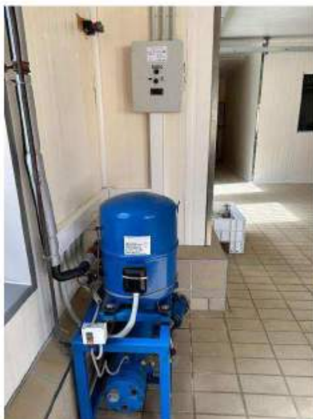
Piano primo. Locale 13: Locale lavorazione prosciutto. Impianto di condizionamento. Mod. Travaglini K740CC. 3 Kw. Anno di messa in servizio: 2005. Cod.03A-004
