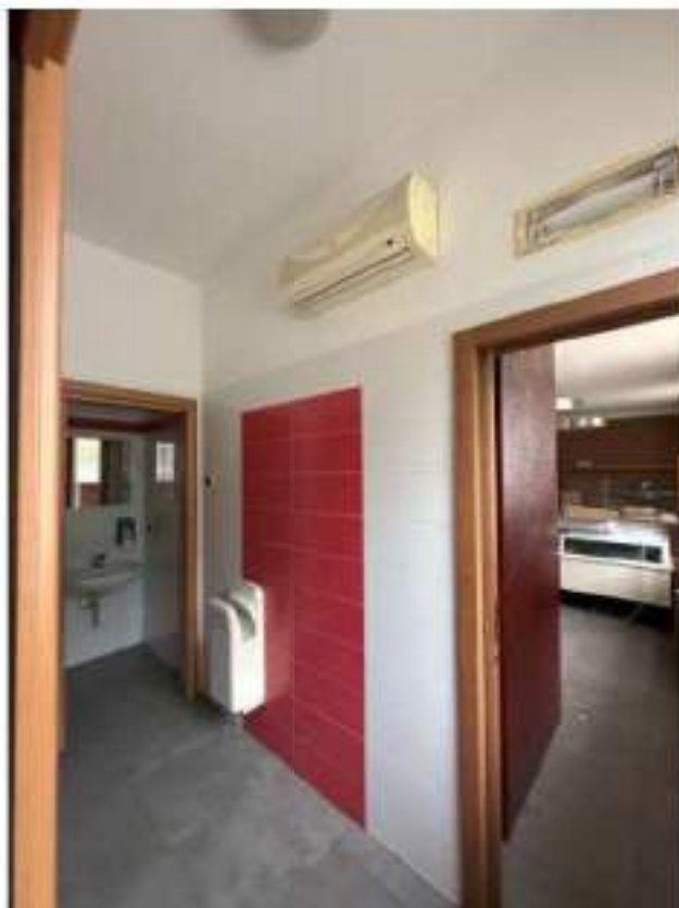
Impianto di condizionamento bagno clienti. Condizionatore locale bagni Mod. Climair. 1,000 Kw a inverter. Anno di messa in servizio: 2007. Sp.035
