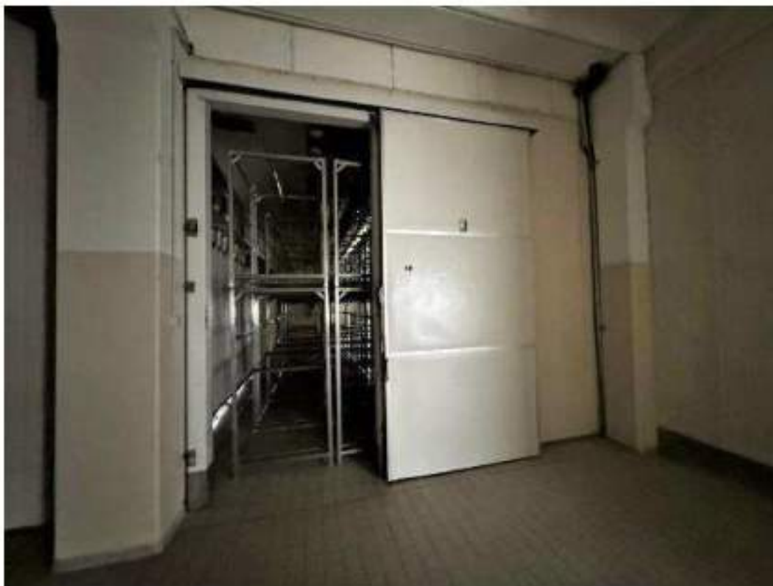
Piano secondo. Cella 4/B: Stagionatura. Mod. Travaglini 2WS/36 PC. Il motore è in comune con il 3B. Anno di messa in servizio: 1985. Particolari finiture interne. Carrelli acciaio inox portasalumi
