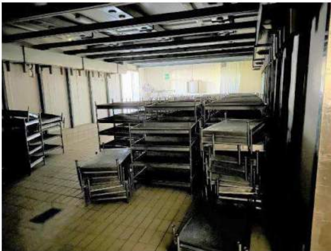
Particolari finiture interne. Piano terra. Cella 10: scongelamento prodotti. Locale scongelamento. Mod Travaglini WSA 140-5328. 15 Kw. Anno di messa in servizio: 1999. Baltresche: scaffalature componibili con ripiani in acciaio inox.
