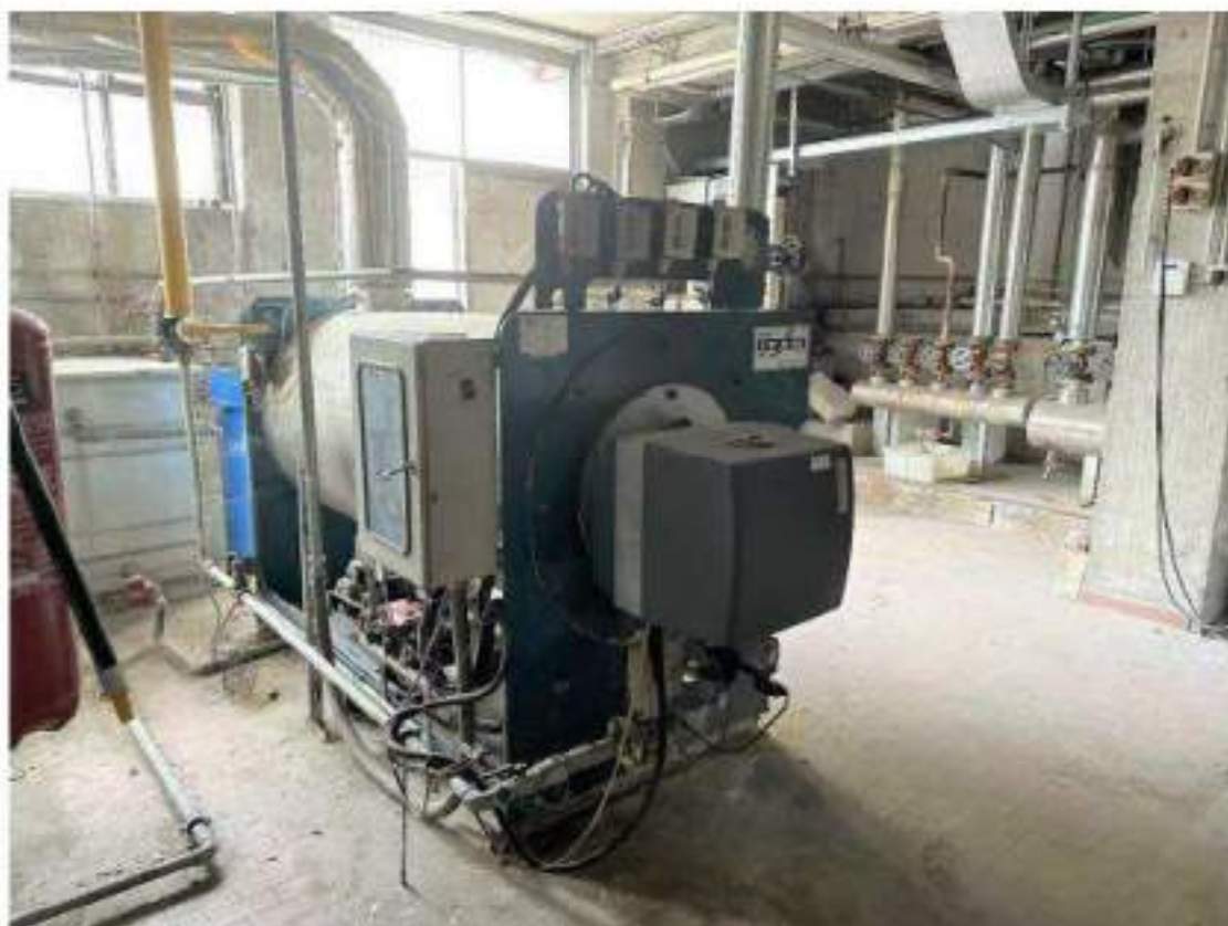
Piano seminterrato C.F. Fg.7 mapp.236 sub.4 : centrale termica 34 - Finiture interne, particolari impianti. Caldaia vapore. Mod. Ivar GVO 750 - 523,25 Kw. Anno di messa in servizio: 1999 Cod. 00-006
