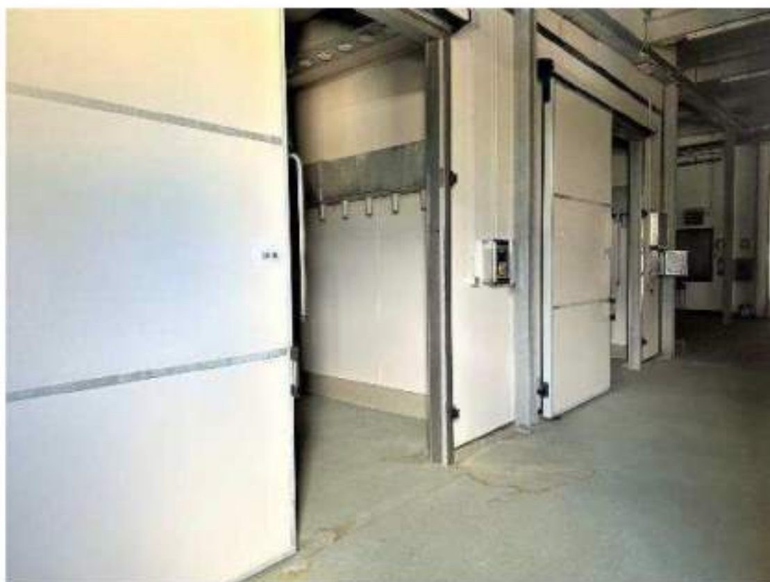
Piano secondo. Cella 14/B: Stagionatura. Mod. Travaglini WDJ350. 25 Kw. Anno di messa in servizio: 2010. Particolari finiture interne.
