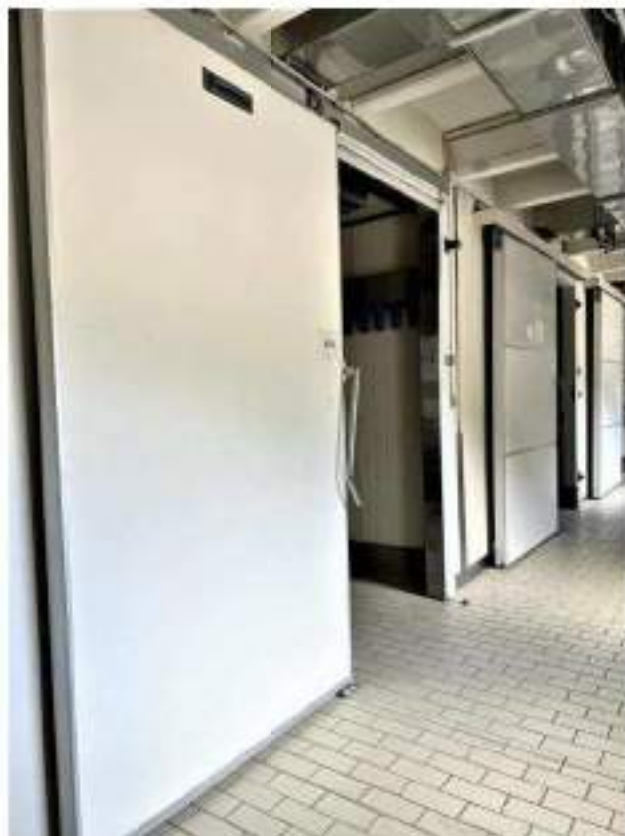
Piano primo. Cella 6/A: asciugamento. Essicatoio. Mod. Travaglini WA 21 P.C. 15 Kw. Anno di messa in servizio: 1984, Particolari finiture interne.
