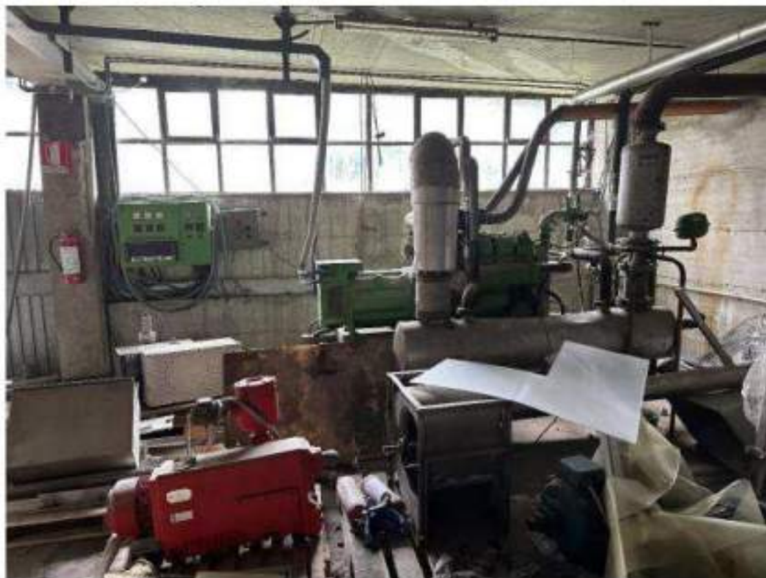
Piano seminterrato C.F. Fg.7 mapp.236 sub.4 : deposito 34/A - Finiture interne – Generatore a gasolio dismesso..
