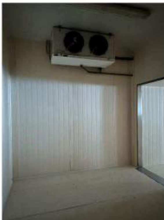
Piano primo. Cella 13/A. Cella stoccaggio affettati. Mod. CRC 040. 2 Kw. Anno di messa in servizio: 1999. Finiture interne
