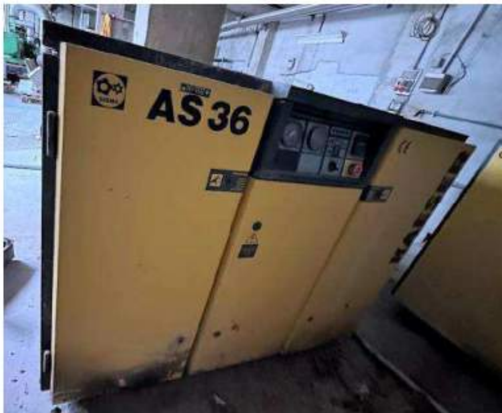
Piano seminterrato C.F. Fg.7 mapp.236 sub.4 : deposito 34/A - Finiture interne. Compressore aria. Mod. Kaeser AS 36. Anno di messa in servizio: 1997. Cod.00-002 – ore 22.091
