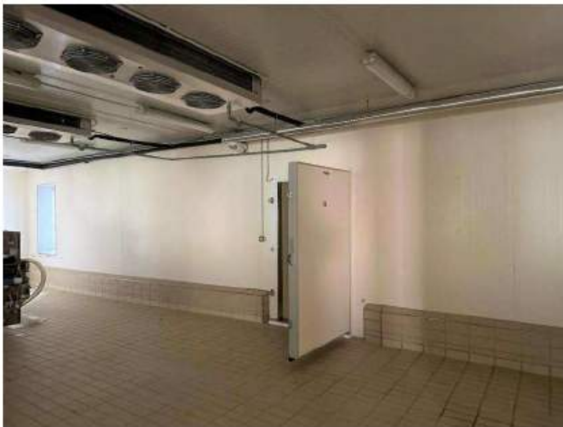
Piano primo. Cella 13/A. Cella stoccaggio affettati. Mod. CRC 040. 2 Kw. Anno di messa in servizio: 1999. Finiture interne
