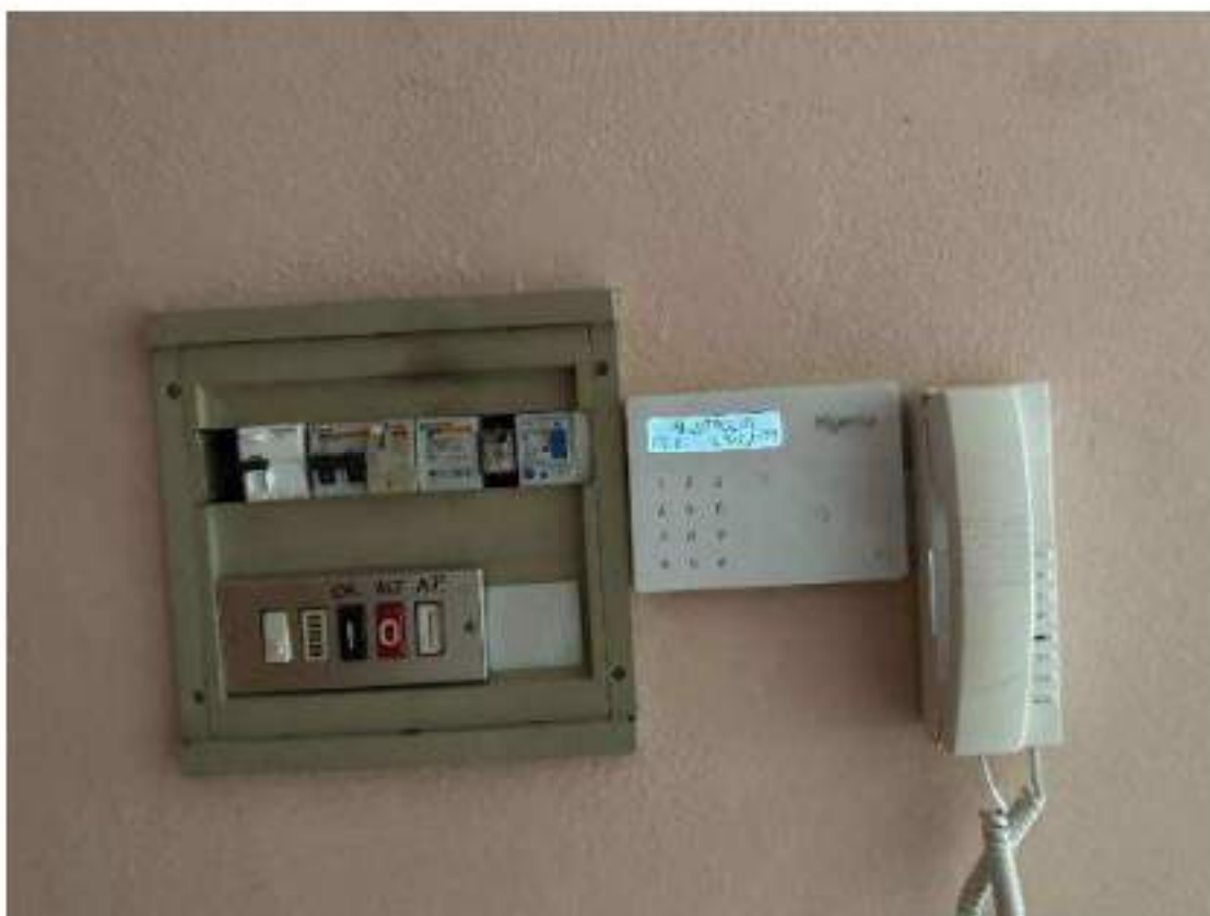
Tastiera impianto allarme, con citofono e quadro elettrico
