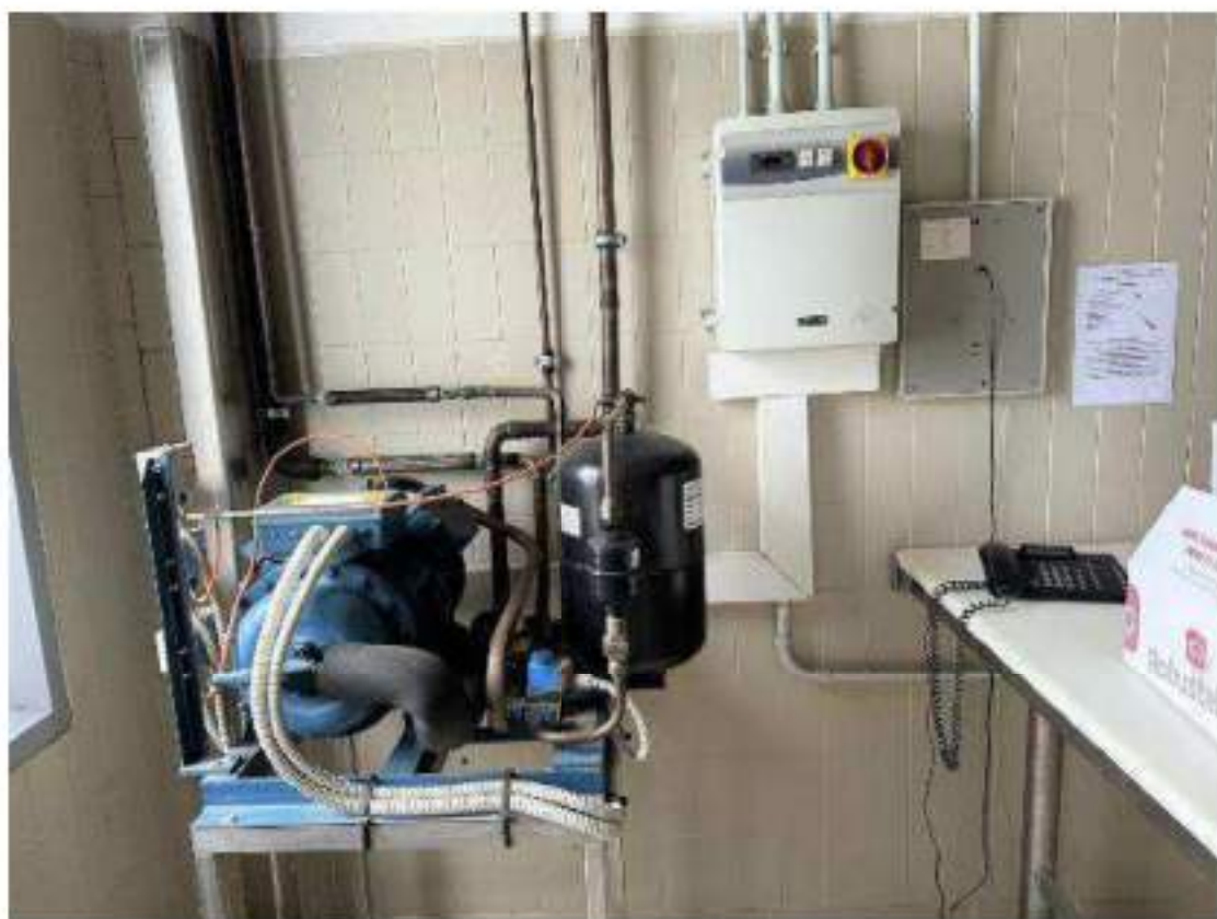
Piano secondo. Locale 15. Appendimento prosciutti. Impianto di condizionamento. Mod. S.A.R.F.E. AUT 007. 6,5 Kw, Cod.01B-009
