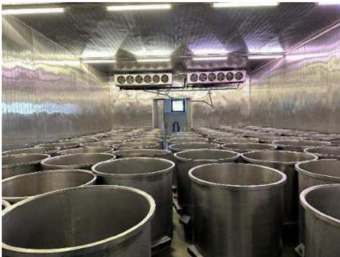
Particolari finiture. Piano terra. Cella 4: stagionatura prosciutto. Cella 0 > 2° salagione suino. Mod Travaglini 7509-13/2. 8,5 Kw. Anno di messa in servizio: 1992. Particolari finiture contenitori cilindrici in acciaio per prosciutti.
