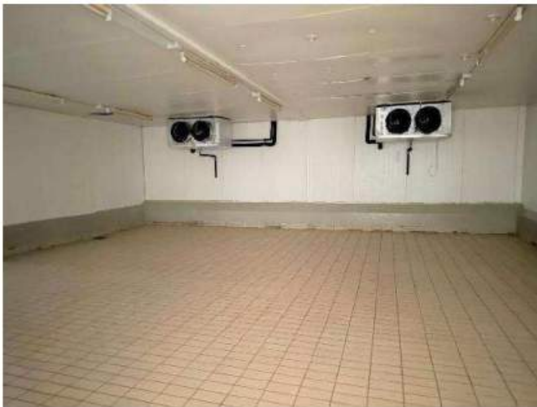
Particolari finiture interne. Piano terra. Cella 7: cella salagione bovino. Cella 0 > 2° salagione bovino. Mod Travaglini. CRC 190. 10 Kw. Anno di messa in servizio: 1993
