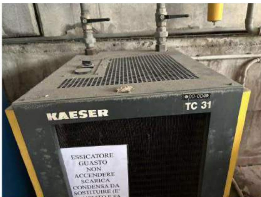
Piano seminterrato C.F. Fg.7 mapp.236 sub.4 : deposito 34/A - Finiture interne Essiccatore d'aria. Mod. Kaeser TC 31. Anno di messa in servizio: 1997. Cod.00-004. Non funzionante, con serbatoio aria
