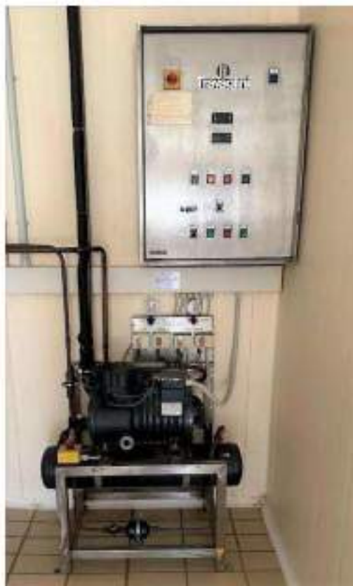
Piano primo. Locale 13: Locale lavorazione prosciutto. Impianto di condizionamento. Mod. Travaglini K740CC. 3 Kw. Anno di messa in servizio: 2005. Cod.03A-004
