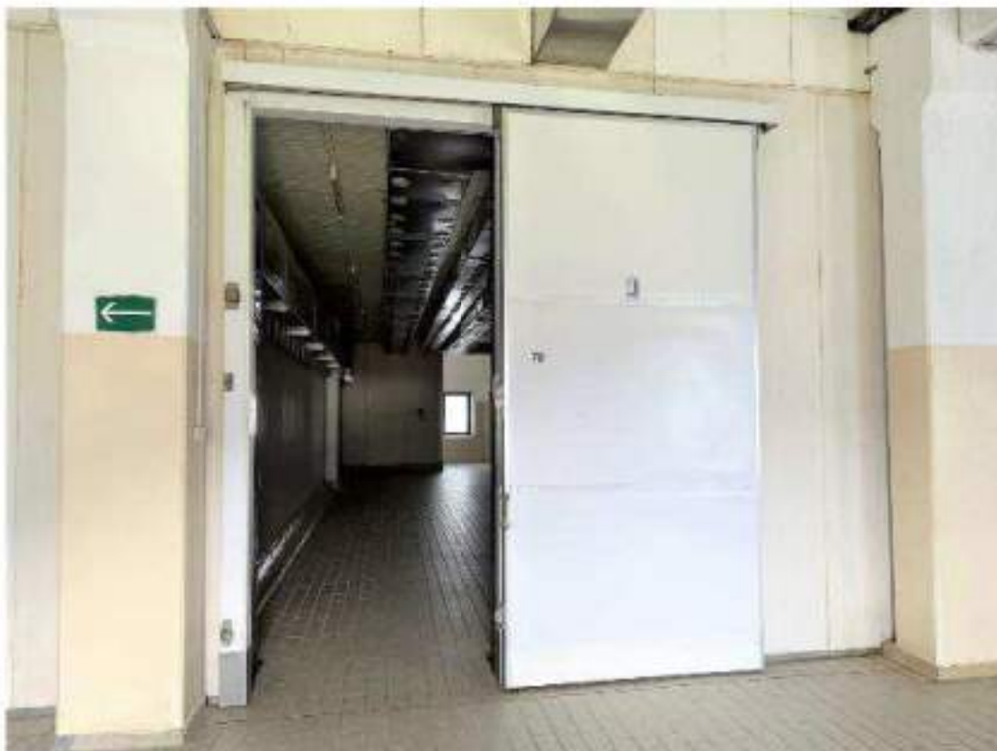
Piano secondo. Cella 7/B: Stagionatura. Mod. Travaglini WS 51. 25,3 Kw. Anno di messa in servizio: 1985. Particolari finiture interne.
