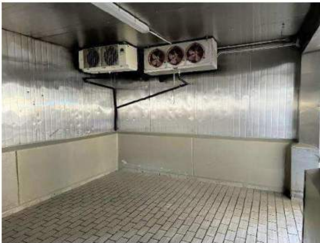
Particolari finiture. Piano terra. Cella 1: deposito sottovuoto. Cella 0 > 2° stoccaggio prodotto finito. Mod Travaglini CRC 045. 3 Kw Anno di messa in servizio: 1993
