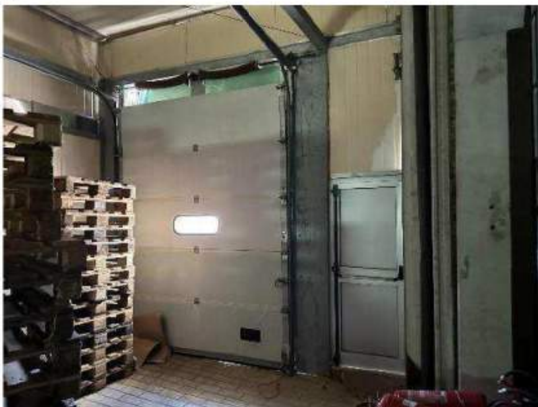
Piano terra. Locale 35: Particolari finiture. Locale smistamento pacchi e carico su autocarri, posto in aderenza al locale 21, accessibile da portone scorrevole, costituito da struttura con telai in alluminio e telo cerato, parete in lamiera coibentata a sud, accessi carico e scarico a est/ovest da portina e basculante sezionale. Bancali di legno, carica batteria muletto, estintori varie misure
