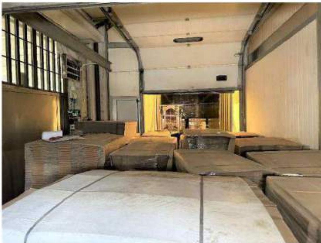
Piano terra. Locale 18A: Scarico carne fresca. Particolari finiture porzione costruita in aderenza, accessibile da portone scorrevole in lamiera, costituita da pareti con pannelli coibentati, apertura con basculante sezionale su container.
