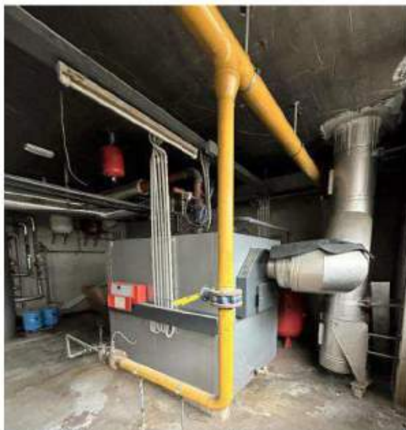
Piano seminterrato C.F. Fig.7 mapp.236 sub.4 : centrale termica 34 - Finiture interne, particolari impianti. Caldaia. Mod. Viessman. VITOPLEX 100 - SX 1 + pompe. Anno di messa in servizio: 2008 Cod.00-005
