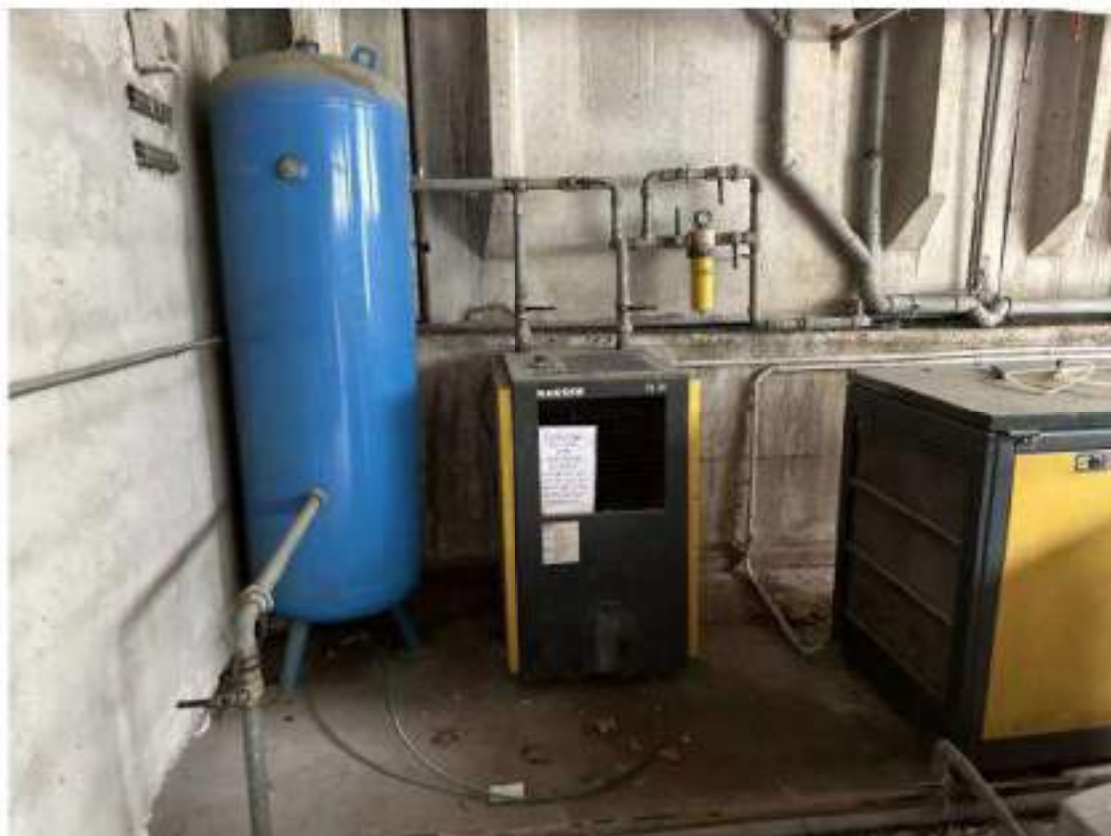
Piano seminterrato C.F. Fg.7 mapp.236 sub.4 : deposito 34/A - Finiture interne Essiccatore d'aria. Mod. Kaeser TC 31. Anno di messa in servizio: 1997. Cod.00-004. Non funzionante, con serbatoio aria
