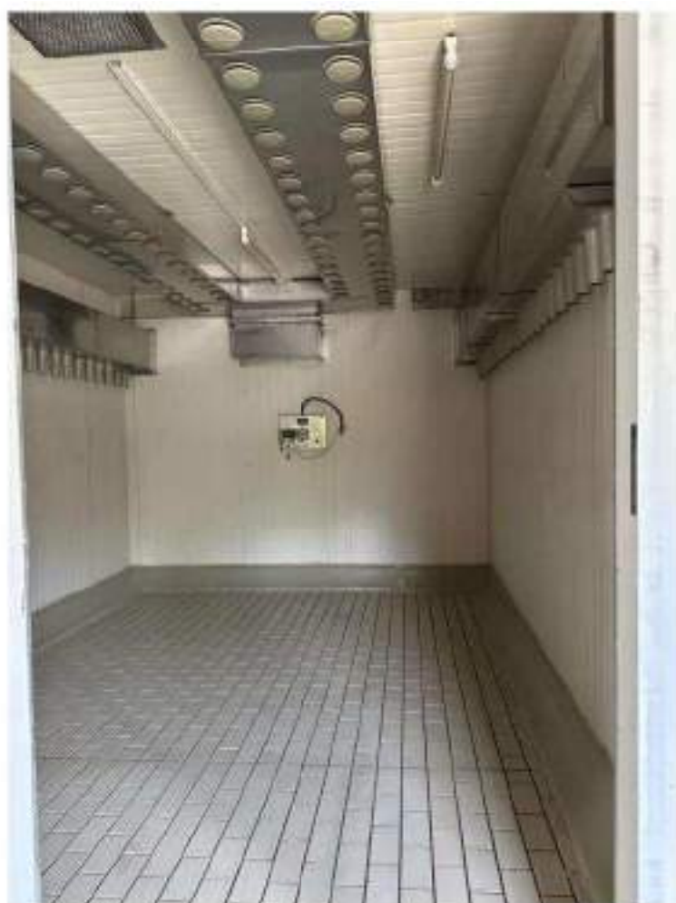
Piano primo. Cella 5/A: asciugamento. Essiccatore. Mod. Travaglini WA 12 P.C. 16 Kw. Anno di messa in servizio: 1985, Particolari finiture interne.
