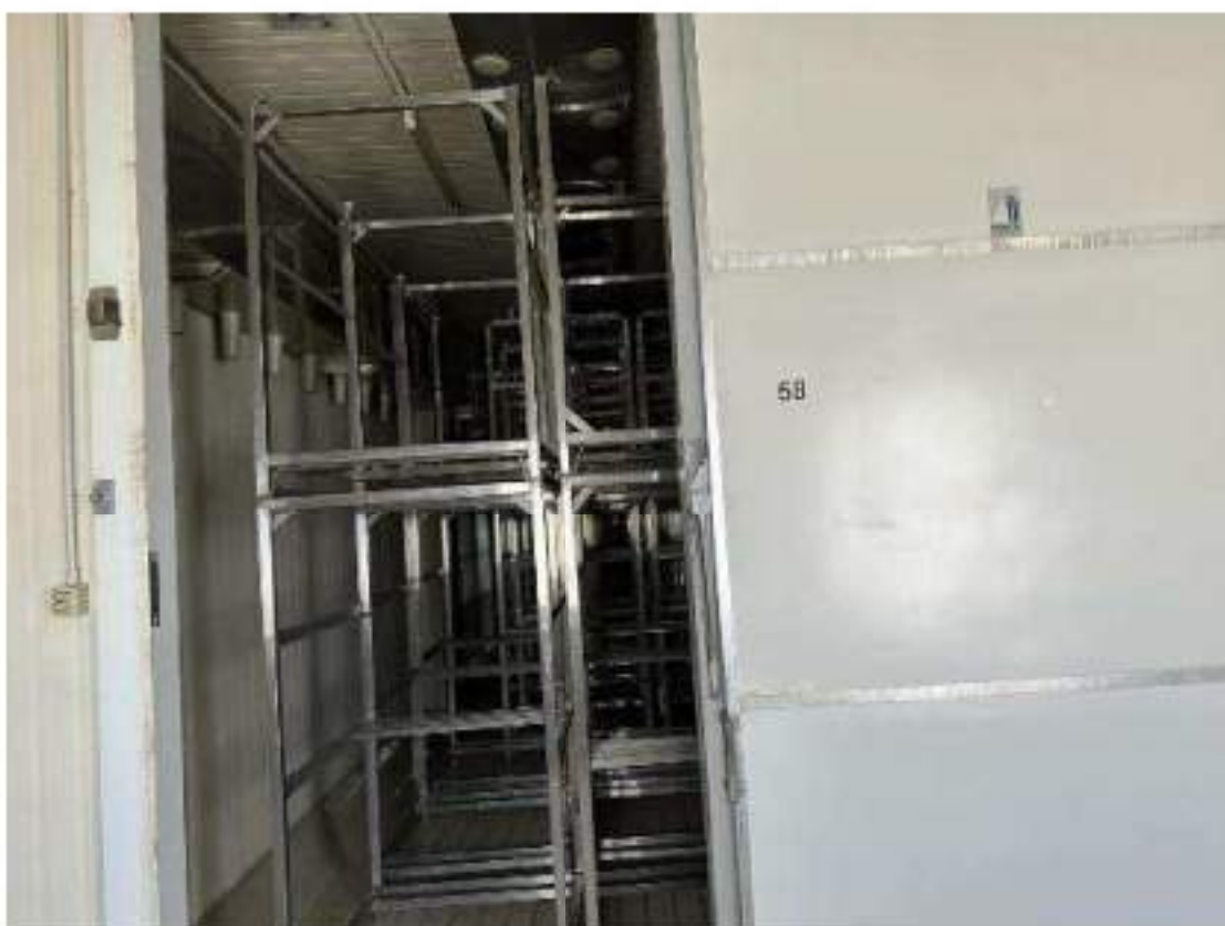
Piano secondo. Corridoio lato nord e Cella 5/B: Stagionatura. Mod. Travaglini WS 51. 25,3 Kw. Anno di messa in servizio: 1985. Particolari finiture interne. Carrelli acciaio inox portasalumi.
