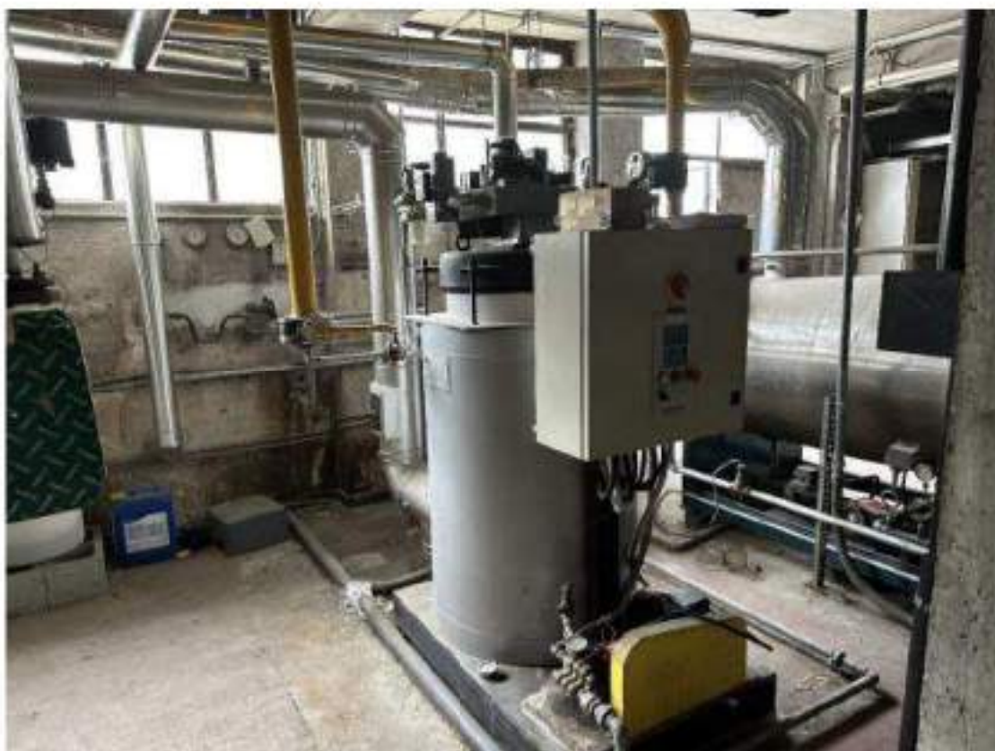
Piano seminterrato C.F. Fg.7 mapp.236 sub.4 : centrale termica 34 - Finiture interne, particolari impianti. Caldaia vapore. Mod. Garioni GMT-V 20. 139,50 Kw. Anno di messa in servizio: 2010. – Cod.00-007
