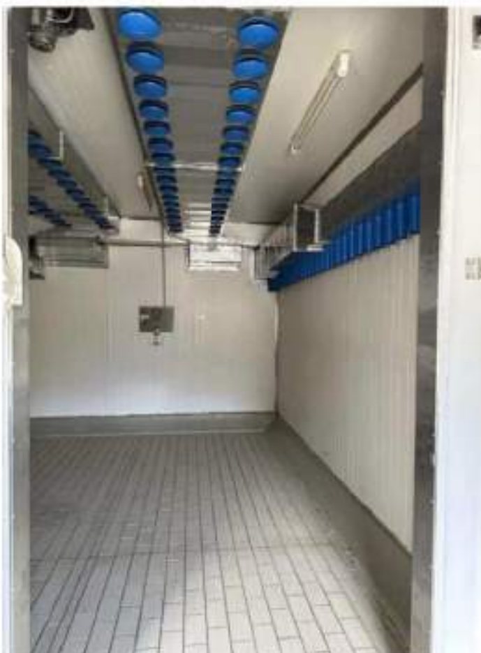
Piano primo. Cella 6/A: asciugamento. Essicatoio. Mod. Travaglini WA 21 P.C. 15 Kw. Anno di messa in servizio: 1984, Particolari finiture interne.
