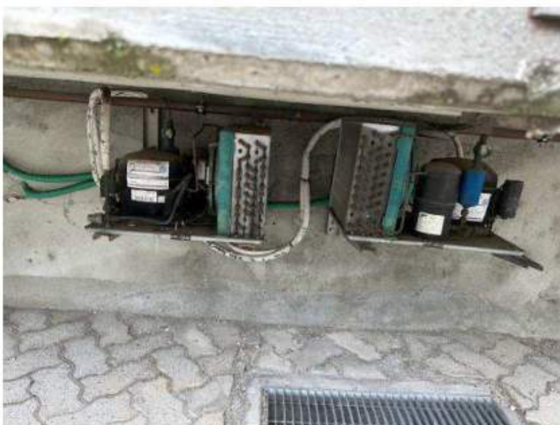
Impianti Frigocassettiera cucina Mod. Embraco Aspera. 0,700 Kw. Cod.Sp-001, e Frigoarmadio cucina Mod. Embraco Aspera. 0,700 Kw. Cod.Sp-002. ubicati esternamente sull'area di pertinenza a sud censita al mappale 230.
