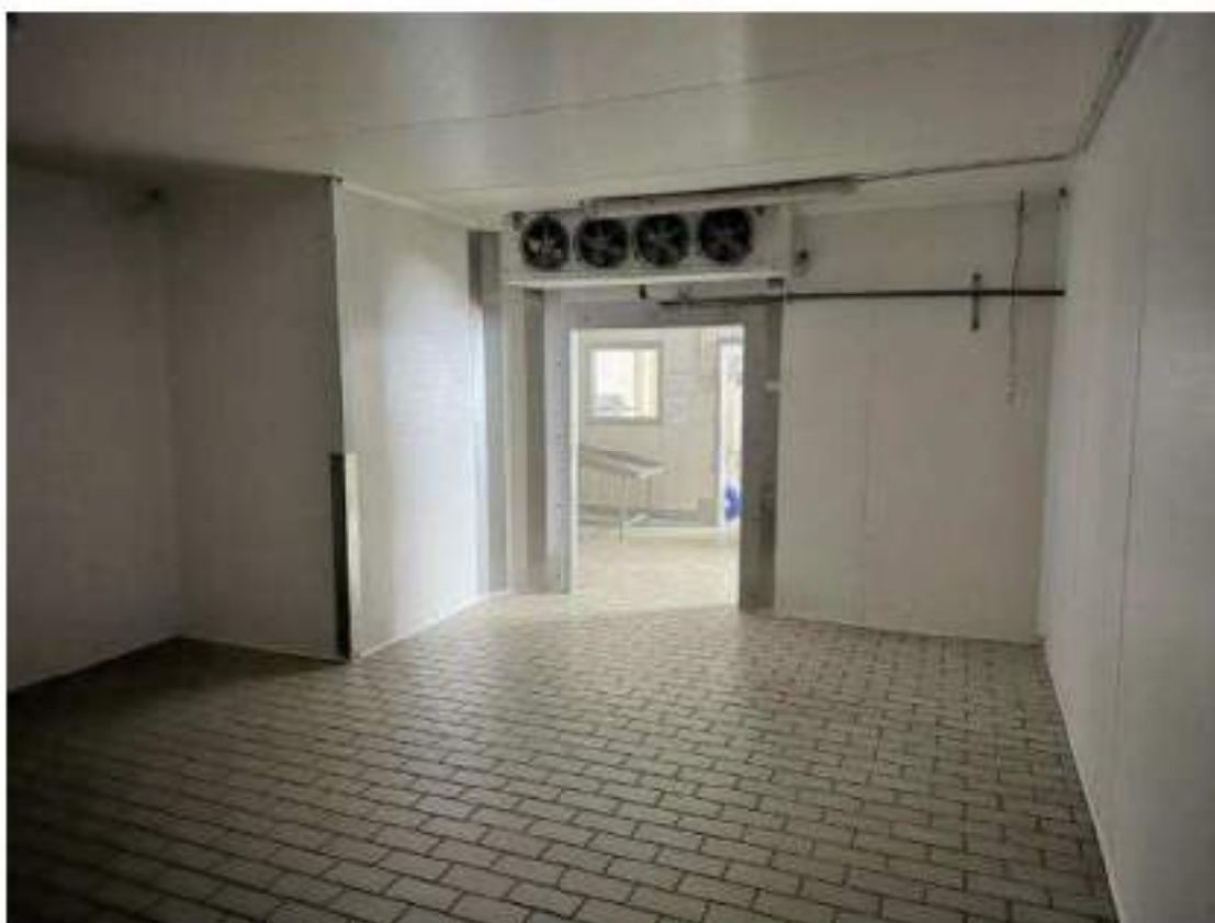
Piano primo. Locale 12/A: Cella prodotto finito sottovuoto. Cella 0 > 2° stoccaggio prodotto finito. Mod Travaglini AUT 03. 3,1 Kw. Anno di messa in servizio: 2009. Particolari finiture interne.
