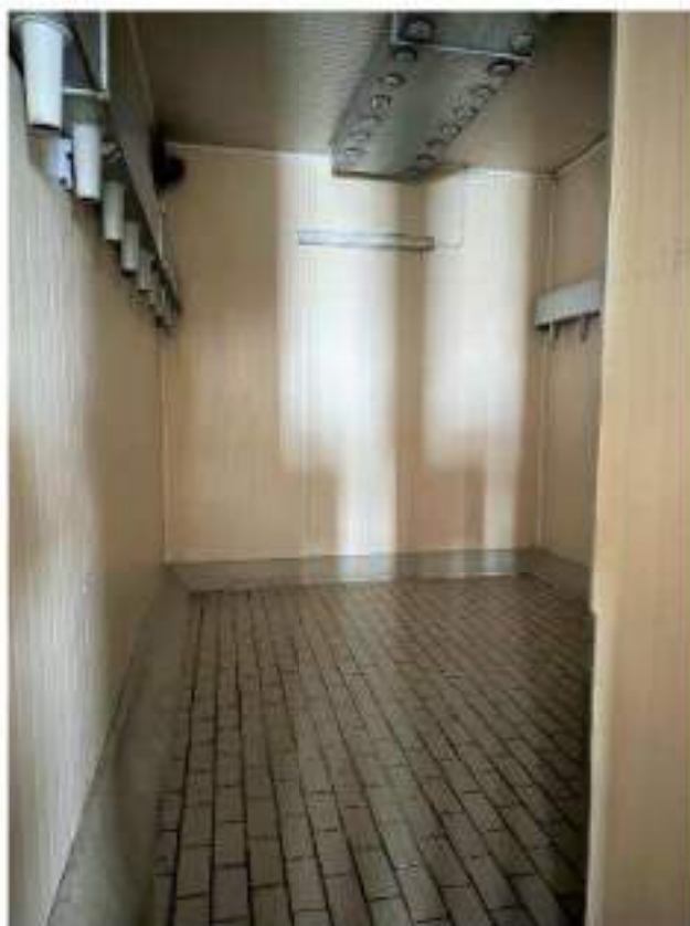
Piano secondo. Cella 11/B: Stagionatura. Mod. Travaglini WS 120.1453. 8 Kw. Anno di messa in servizio: 1990. Particolari finiture interne.
