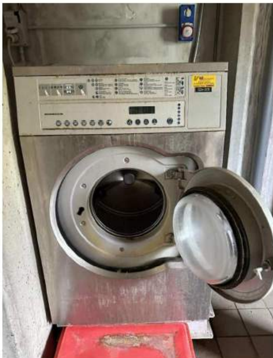
Piano primo locale 33. Lavatrice industriale. Mod. Zanussi W375H. 7,8 Kw. Anno di messa in servizio: 2012. Cod. 00-005.
