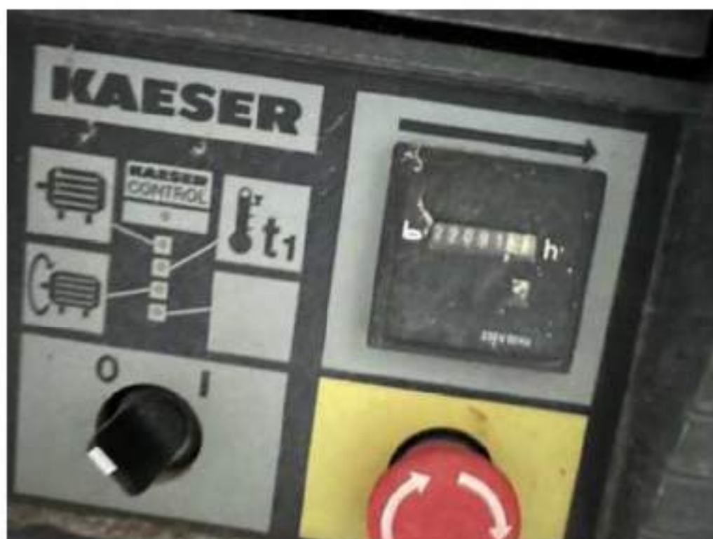
Piano seminterrato C.F. Fg.7 mapp.236 sub.4 : deposito 34/A - Finiture interne. Compressore aria. Mod. Kaeser AS 36. Anno di messa in servizio: 1997. Cod.00-002 – ore 22.091
