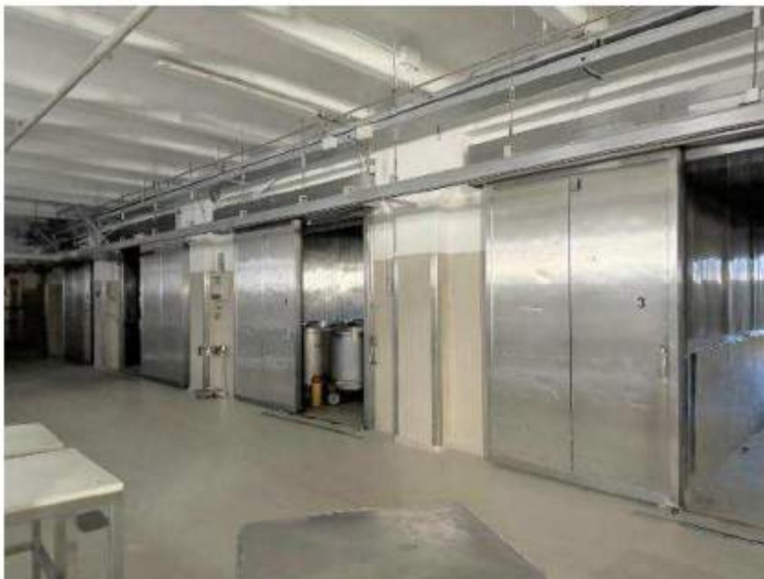
Particolari finiture. Piano terra. Cella 4: stagionatura prosciutto. Cella 0 > 2° salagione suino. Mod Travaglini 7509-13/2. 8,5 Kw. Anno di messa in servizio: 1992. Particolari finiture contenitori cilindrici in acciaio per prosciutti.
