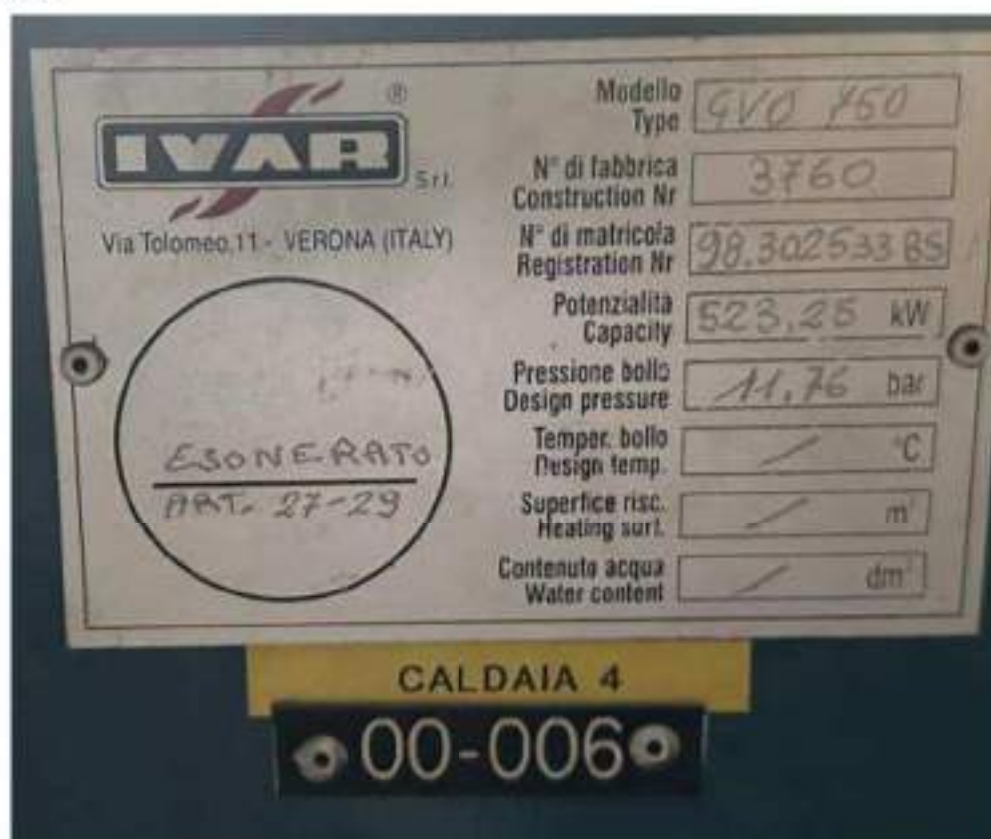
Piano seminterrato C.F. Fg.7 mapp.236 sub.4 : centrale termica 34 - Finiture interne, particolari impianti. Caldaia vapore. Mod. Ivar GVO 750 - 523,25 Kw. Anno di messa in servizio: 1999 Cod. 00-006
