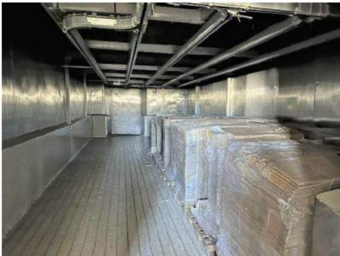
Particolari finiture interne. Piano terra. Cella 6: carne fresca. Cella 0 > 2° salagione suino. Mod Travaglini 7509-13/2. 8,5 Kw. Anno di messa in servizio: 1992. Vista binari a soffitto per trasporto insaccati. Si evidenziano bancali di scatole di cartone.
