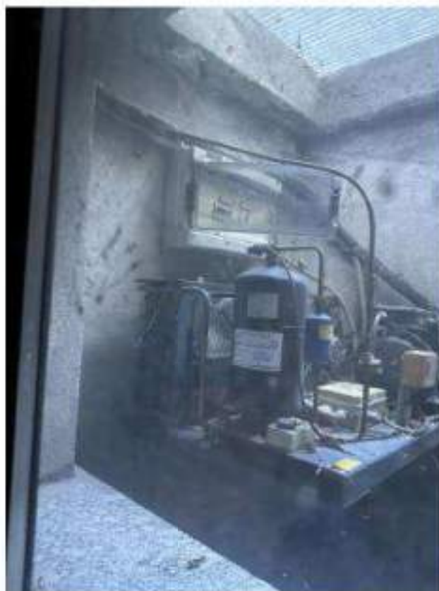
Spaccio. Frigorifero murale Mod. Coldar mac 2. 1,800 Kw. Anno di messa in servizio: 2007. Cod. SP-009. Ubicato nella gola di lupo del deposito al sub.10.
