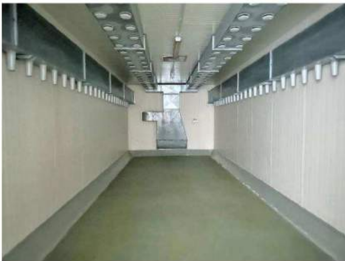
Piano secondo. Cella 13/B: Essiccatoio. Mod. Travaglini WAA 35D, 24 Kw. Anno di messa in servizio: 2006. Particolari finiture interne.
