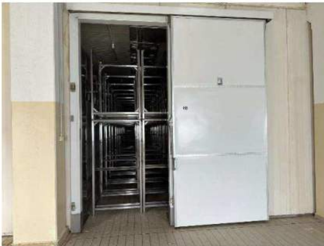
Piano secondo. Cella 6/B: Stagionatura. Mod. Travaglini WS 51. Il motore è in comune con il 5B. Anno di messa in servizio: 1985. Particolari finiture interne. Carrelli acciaio inox portasalumi.
