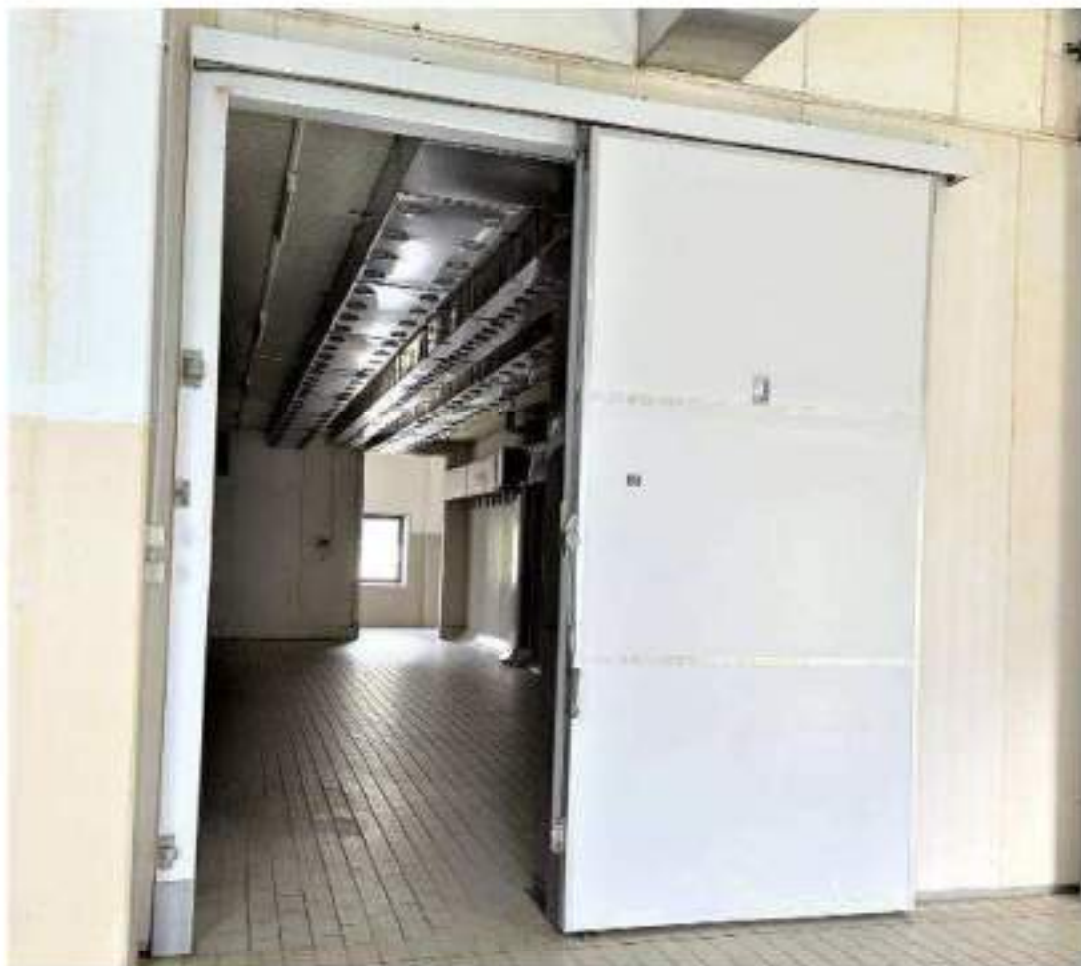
Piano secondo. Cella 8/B: Stagionatura. Mod. Travaglini WS 51. Il motore è in comune con il 7B. Anno di messa in servizio: 1985. Particolari finiture interne.
