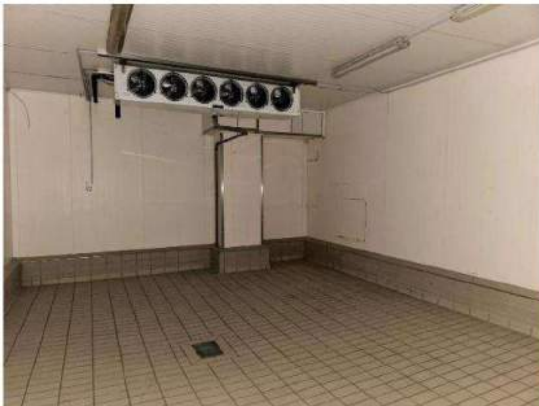
Particolari finiture interne. Piano terra. Cella 9: pressatura speck. Cella 0 > 2° salagione speck. Mod S.A.R.F.E. 5 Kw. Anno di messa in servizio: 2002
