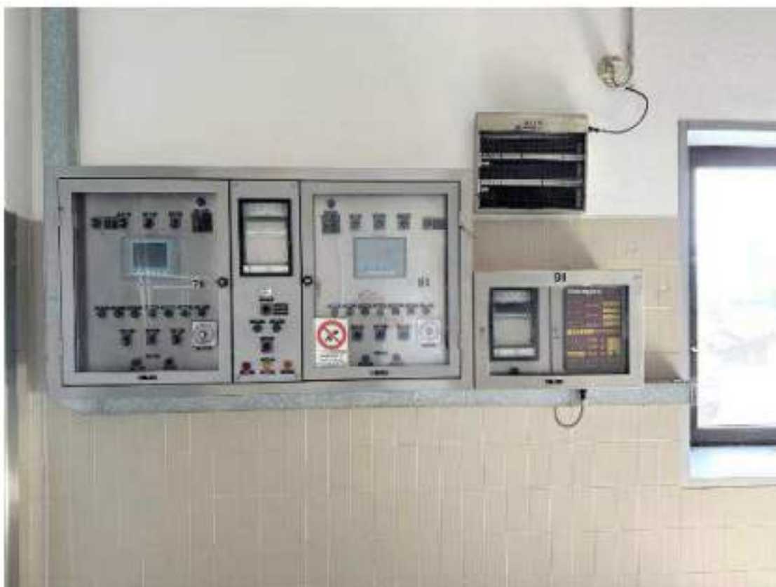
Piano secondo. Quadri di comando celle 7/B-8/B-9/B: stagionatura.
