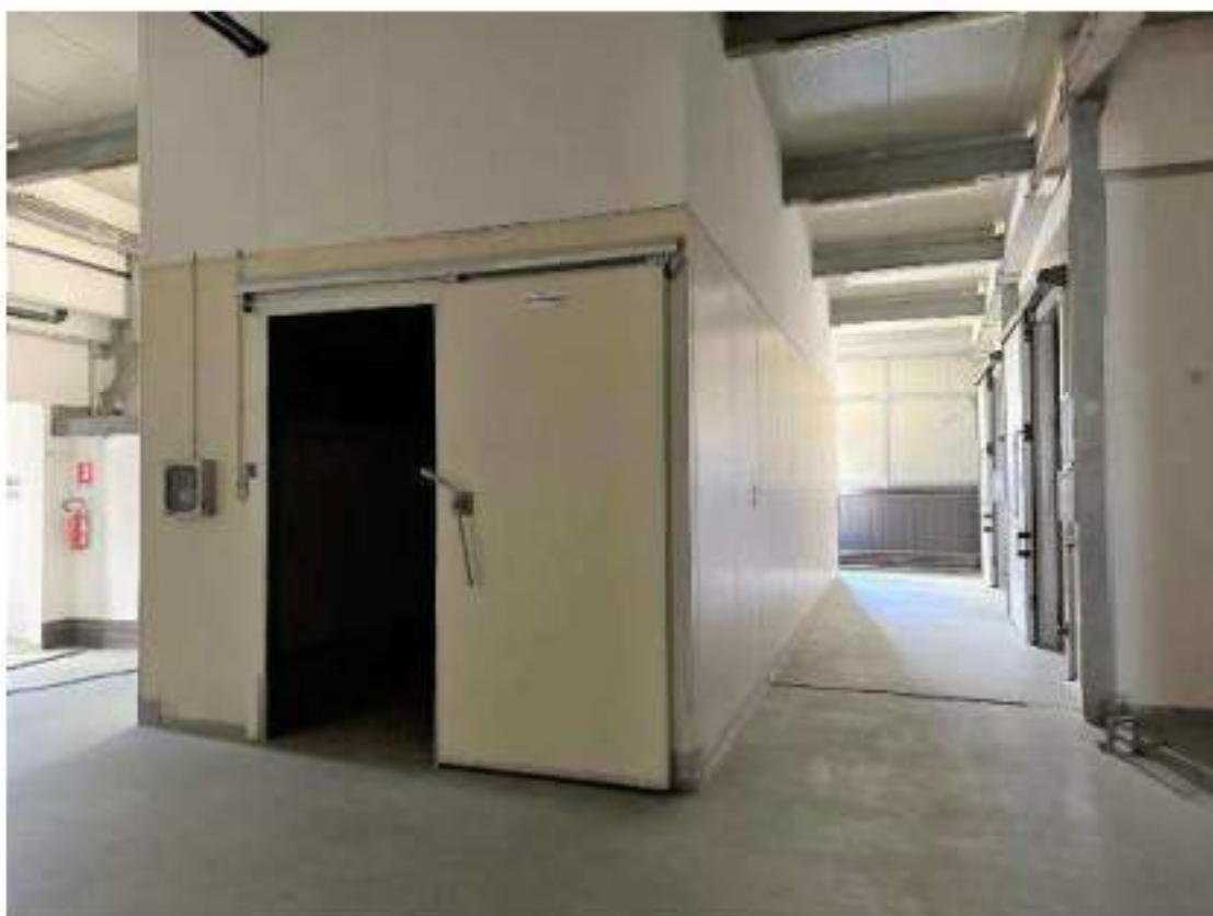
Piano secondo. Cella 13/B: Essiccatoio. Mod. Travaglini WAA 35D, 24 Kw. Anno di messa in servizio: 2006. Particolari finiture interne.
