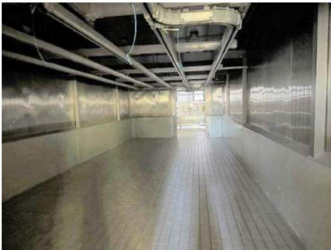
Particolari finiture. Piano terra. Cella 5: carne fresca. Cella 0 > 2° salagione suino. Mod Travaglini 7509-13/2. 8,5 Kw. Anno di messa in servizio: 1992. Vista binari a soffitto per trasporto insaccati
